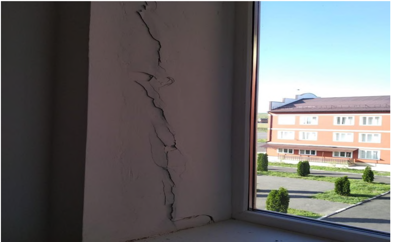
Оконный проем, 3 этаж центральный коридор
