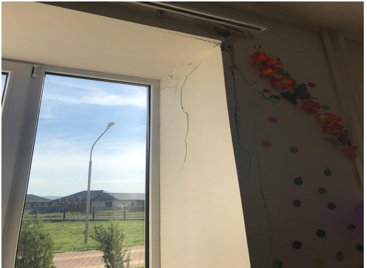
Оконный проем, 3 этаж центральный коридор
