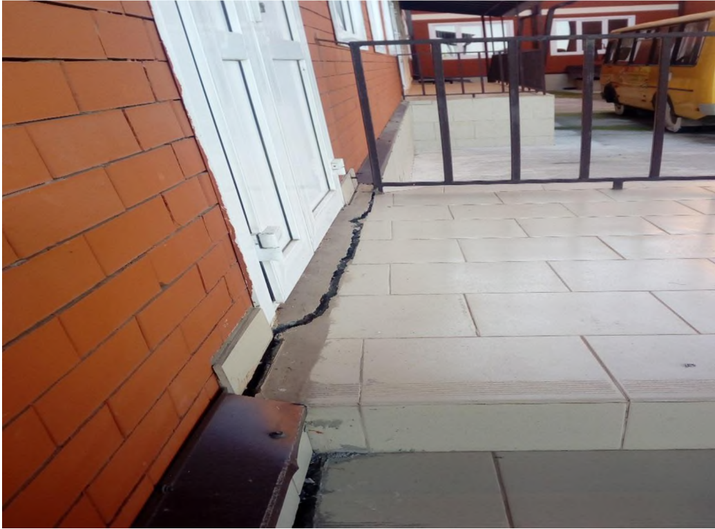
Лестница за фасадной частью центрального входа (запасный выход)
