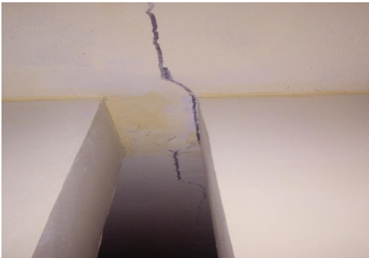
Плита перекрытия цокольного этажа по несущим колоннам
