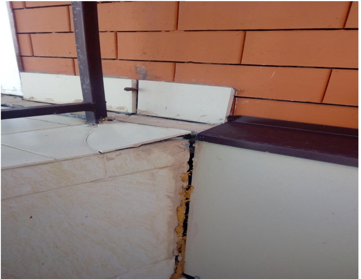
Лестница за фасадной частью центрального входа (запасный выход)
