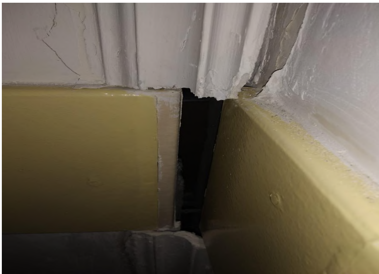
Стена центрального коридора на 2 этаже
