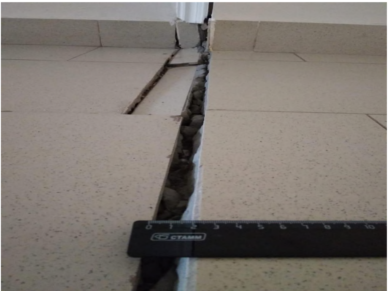
Пол на 2 этаже, центральный коридор
