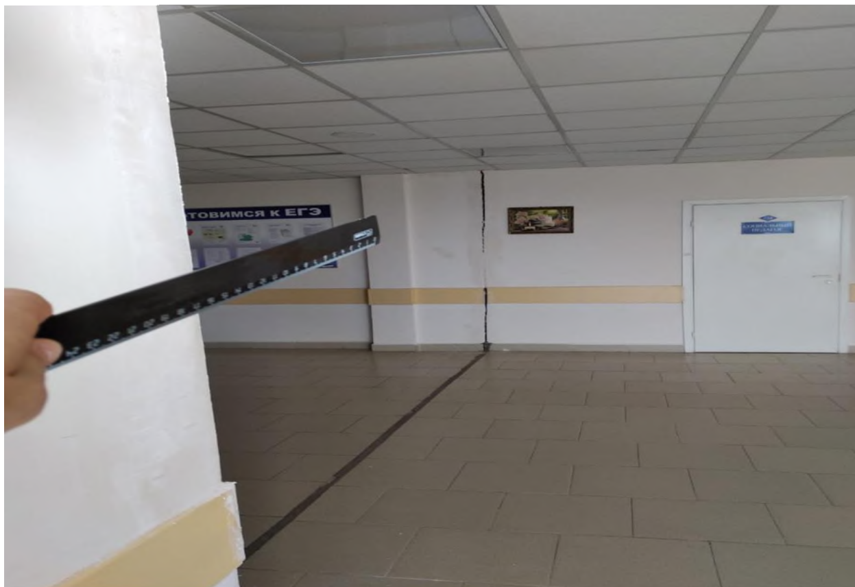
Центральный коридор, 2 этаж
