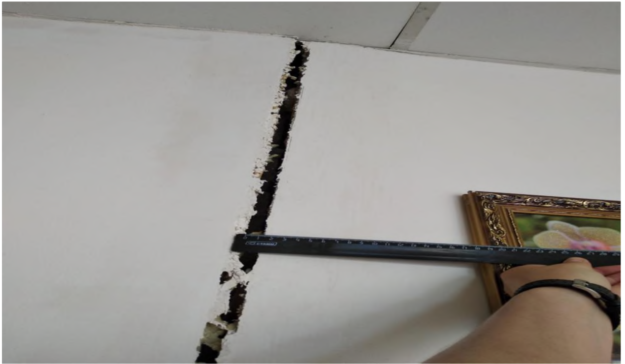
Стена на втором этаже, центральный коридор
