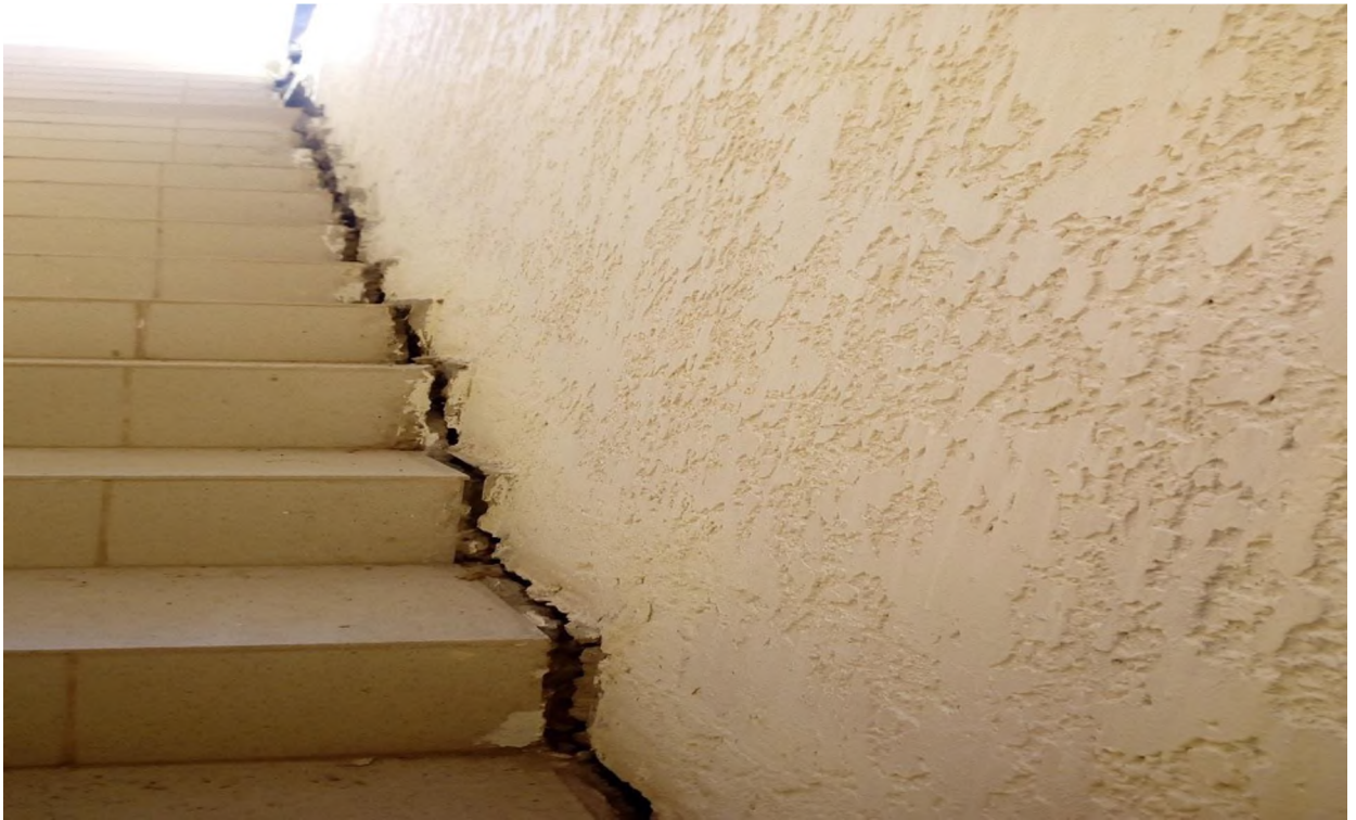
Вход № 1 в подвал цокольного этажа
