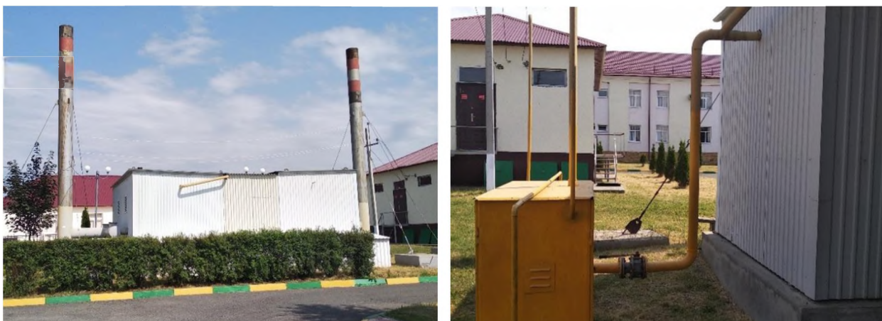
Сооружение котельной с двумя помещениями, подключенной к сетям газоснабжения для нужд Котельной
