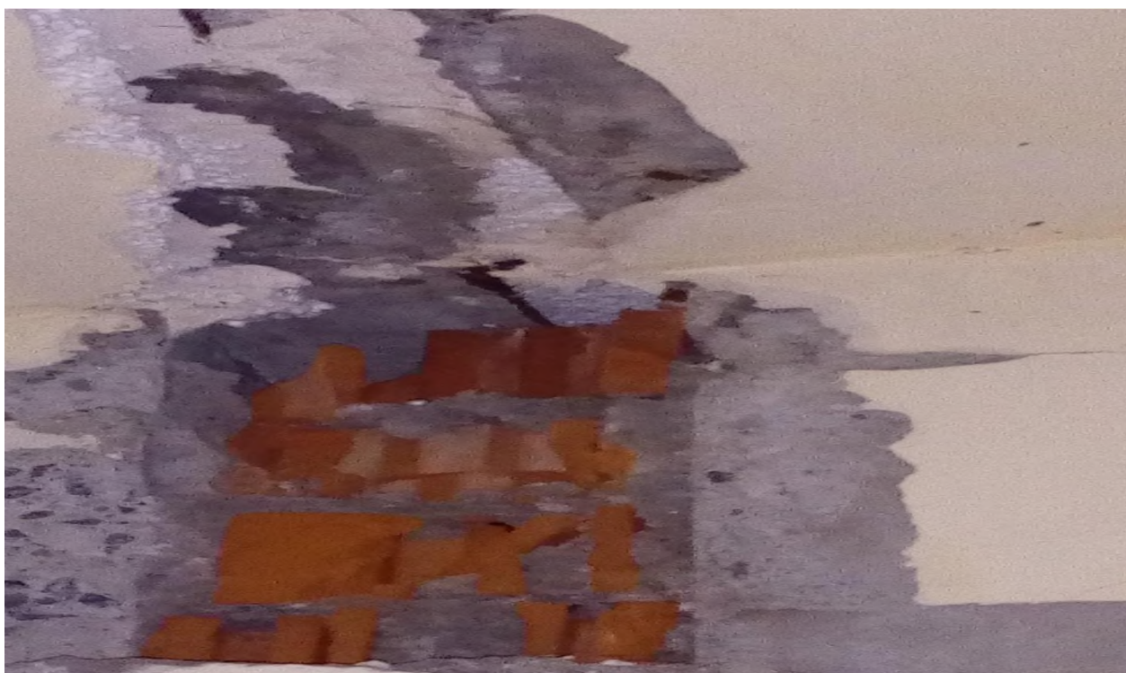
Угол плиты перекрытия по несущим колоннам
