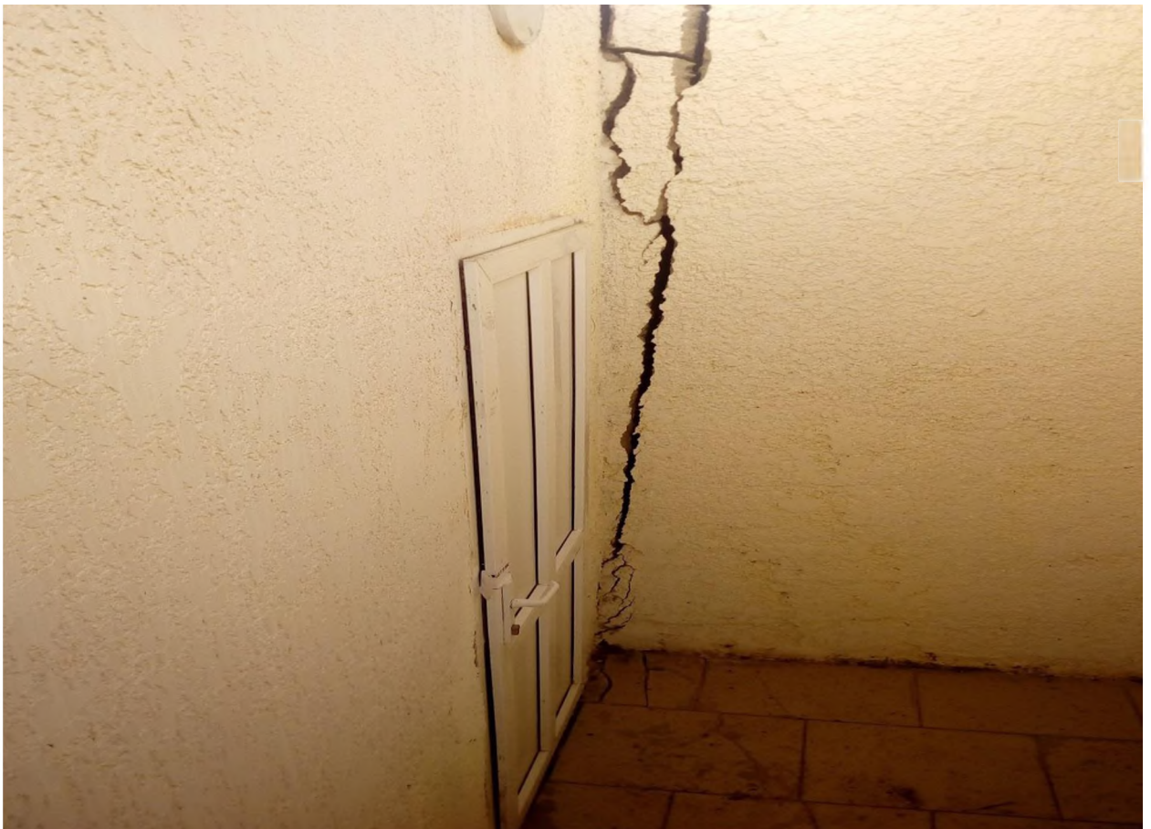
Вход № 1 в подвал цокольного этажа
