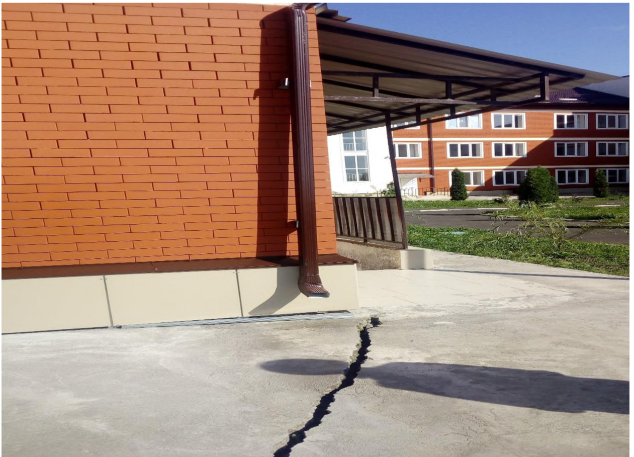
Вход в подвал № 1 в задней части здания
