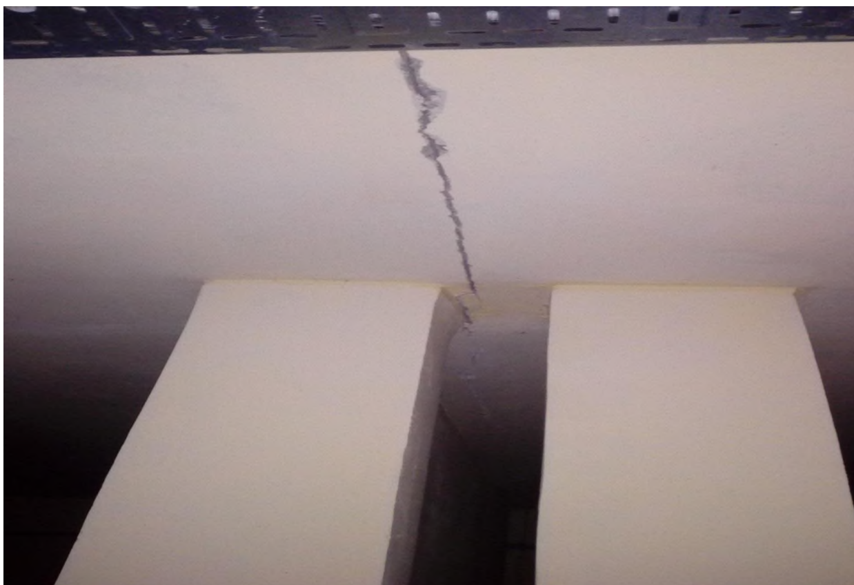
Плита перекрытия цокольного этаж
