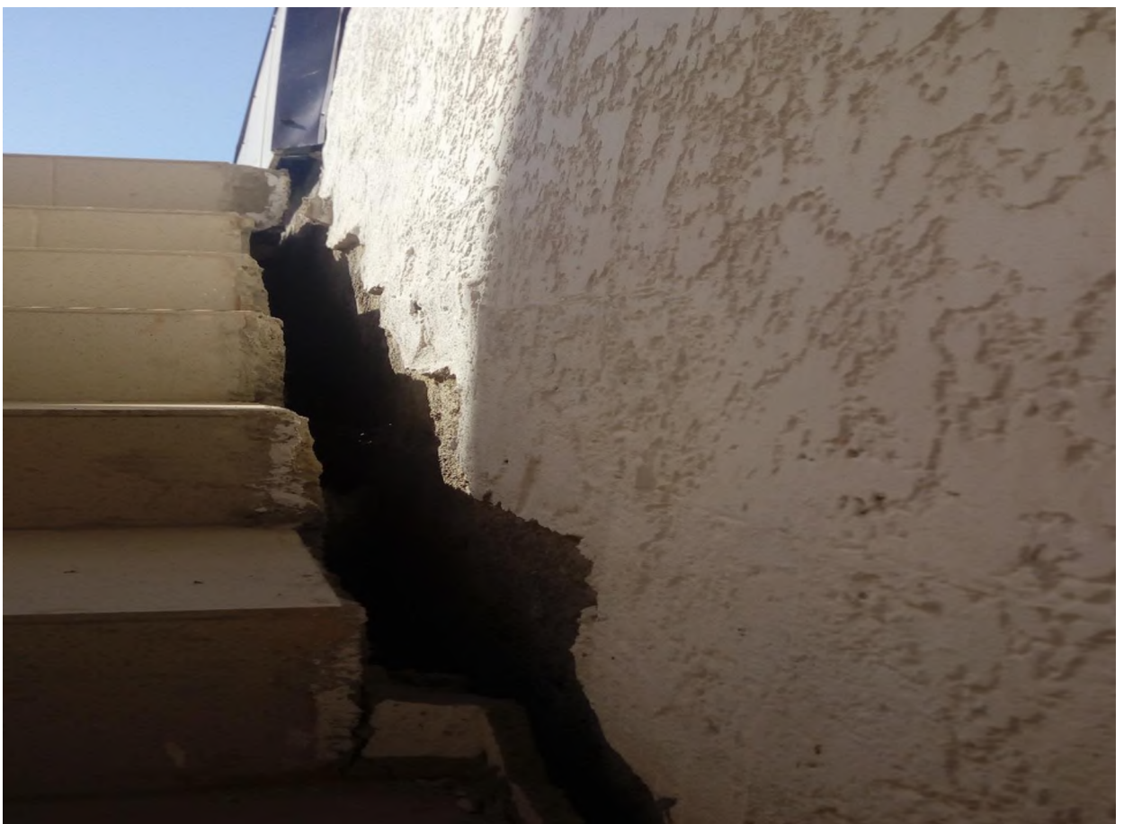
Вход № 1 в подвал цокольного этажа
