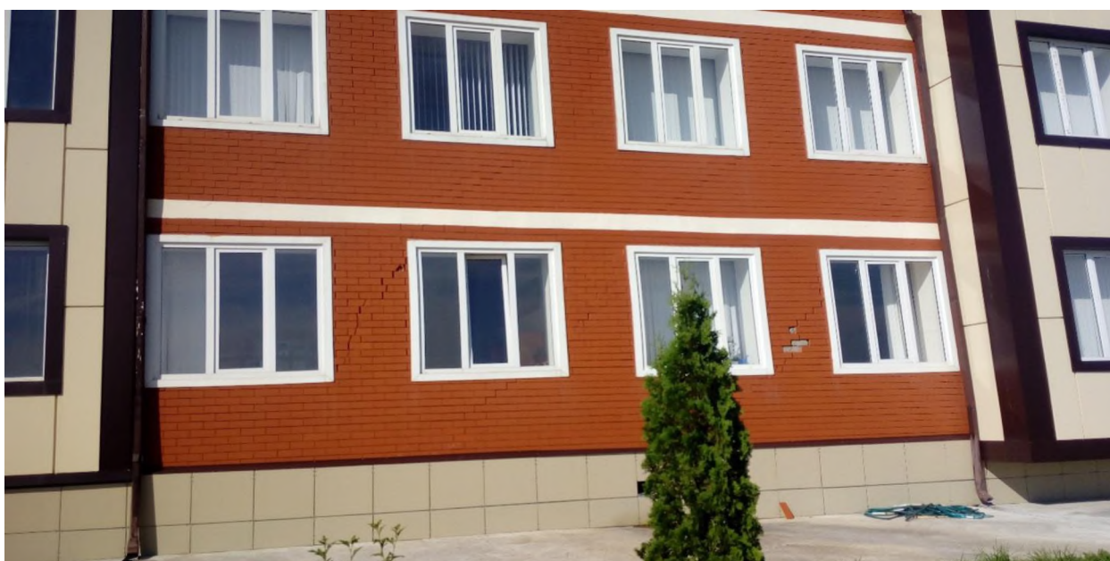
Фасадная стена центрального входа (левая часть)
