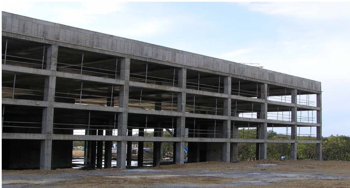
Ход строительства здания гостиницы в развлекательной игровой зоне «Приморье», г. Владивосток (на октябрь 2012 г.)
