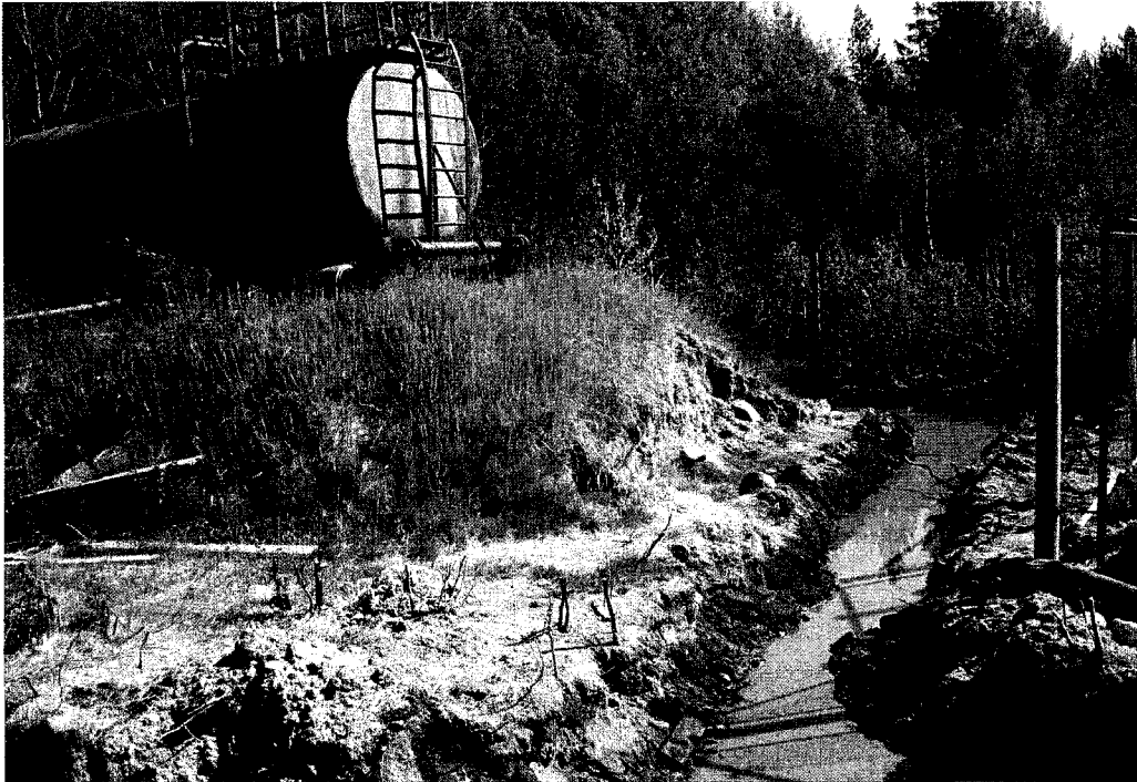
Фото 8. Разлив нефтепродуктов на площадке хранения дизельного топлива
