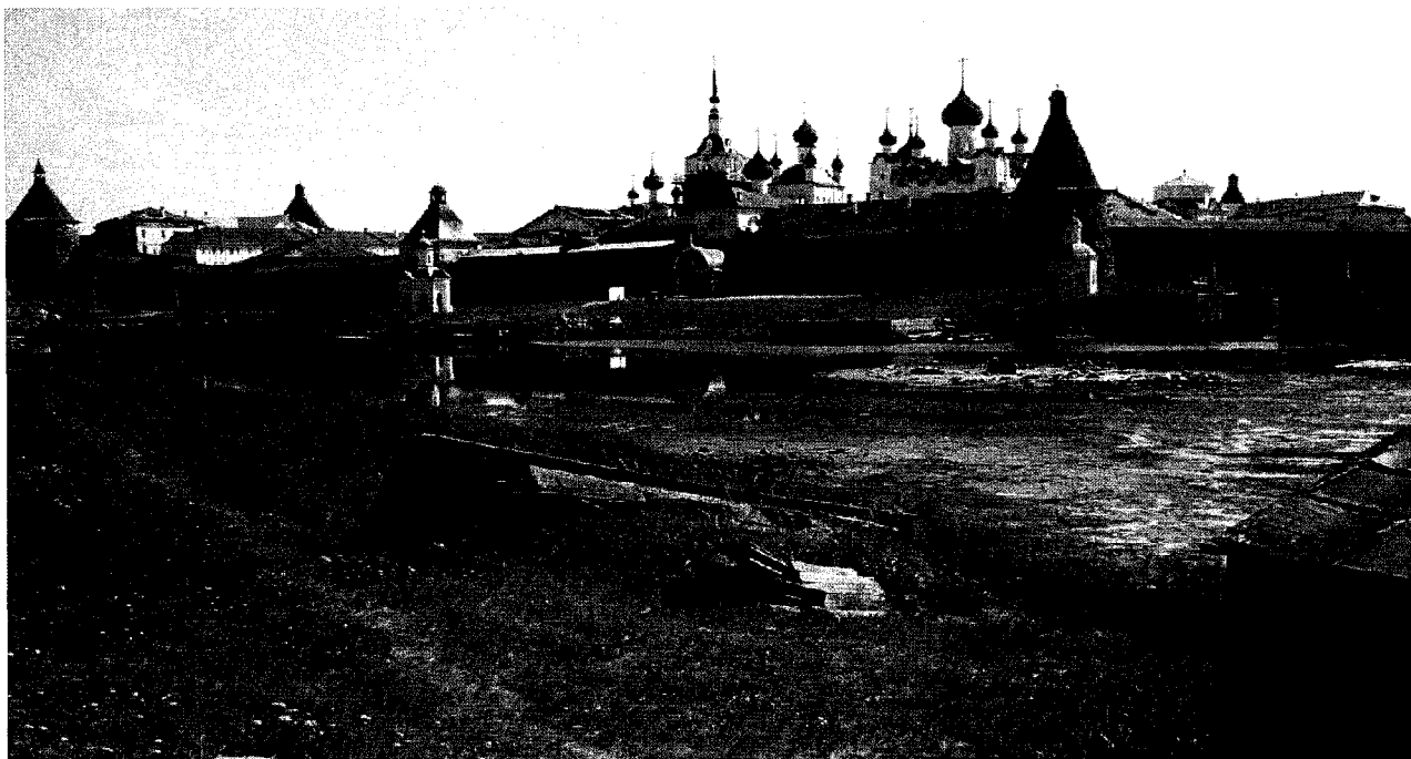
Фото 9. На переднем плане Монастыря - канализационные сливы
