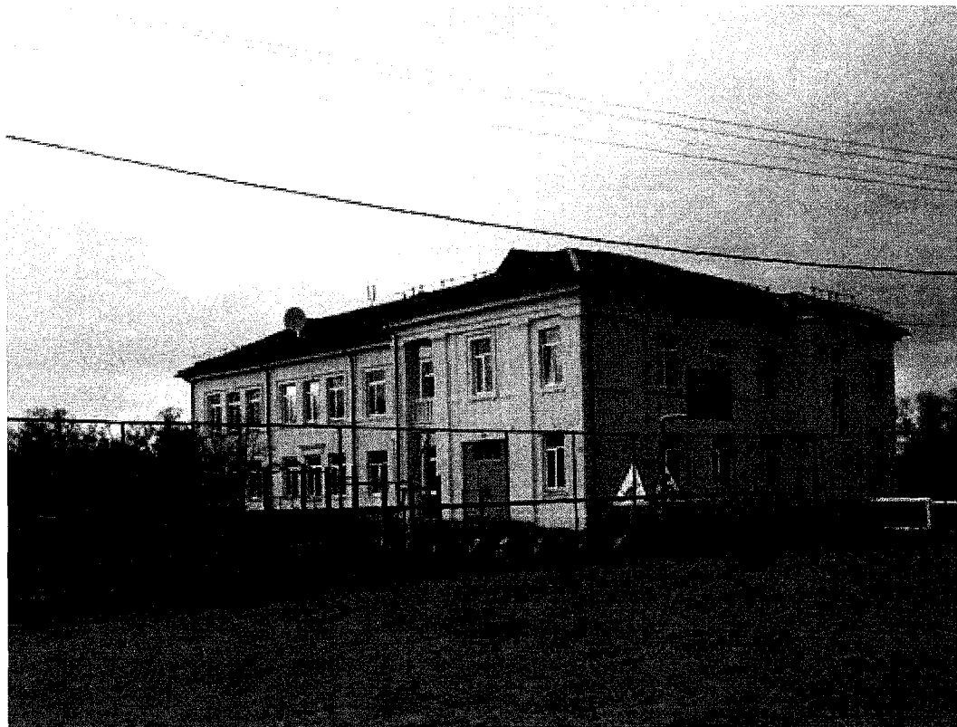
Фото 19. Здание школы после капитального ремонта
