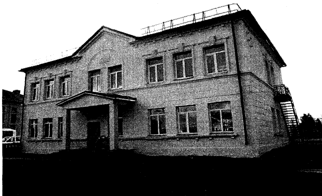
Фото 20. Здание детского сада после капитального ремонта
