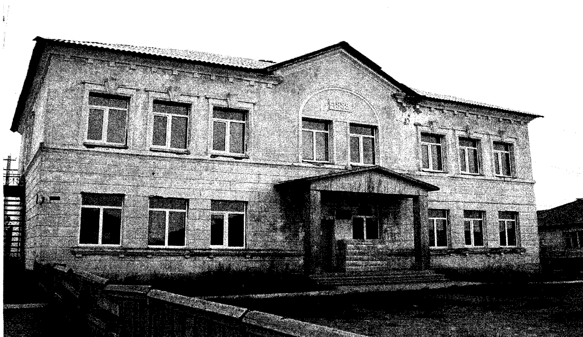
Фото 18. Здание детского сада до капитального ремонта
