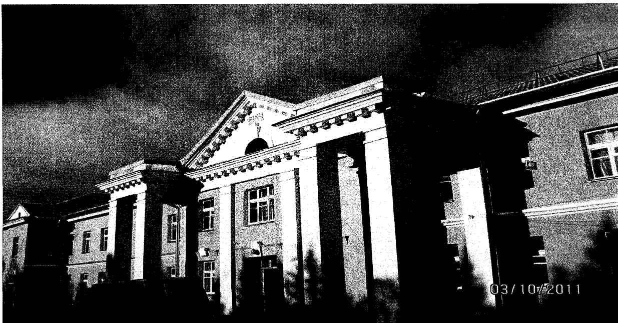
Фото 22. Вид участковой больницы после капитального ремонта
