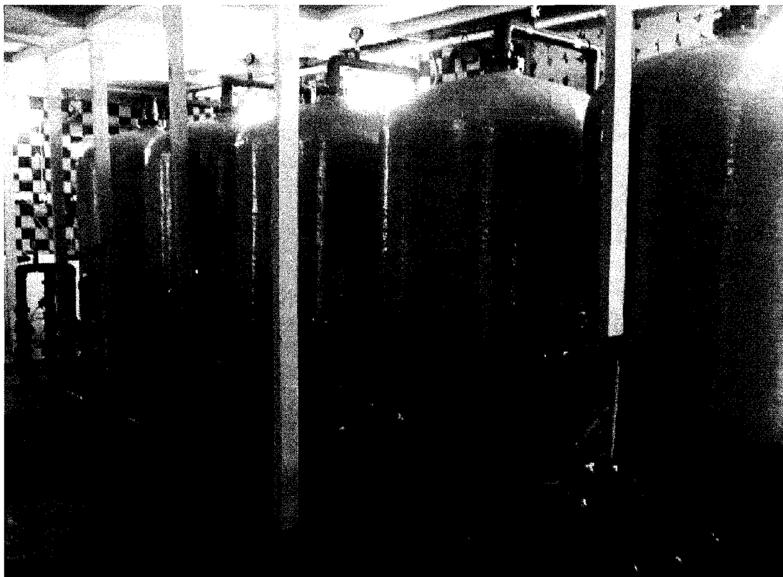
Фото 3. Фильтры 2-го контура очистки воды
