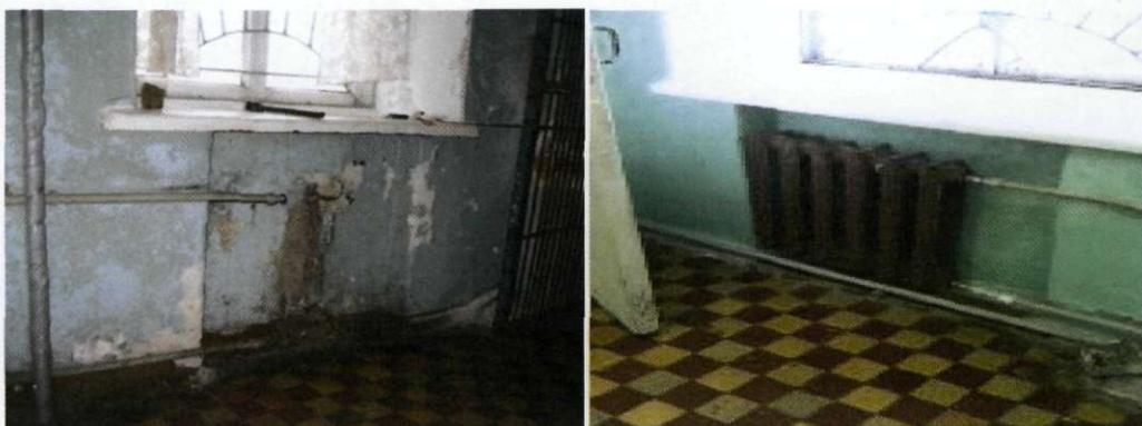
Рис. 16. Отсутствие установленных радиаторов в здании больницы (слева), установленные в ходе проведения контрольного мероприятия радиаторы (справа)
