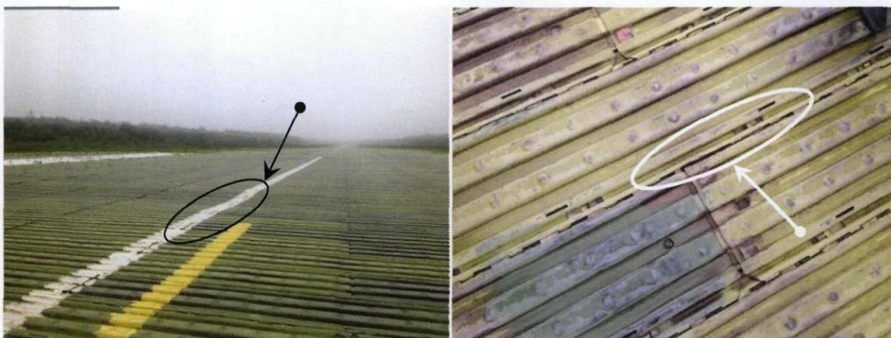
Рис. 10. Деформация покрытия взлетно-посадочной полосы аэропорта «Соловки» (слева).
