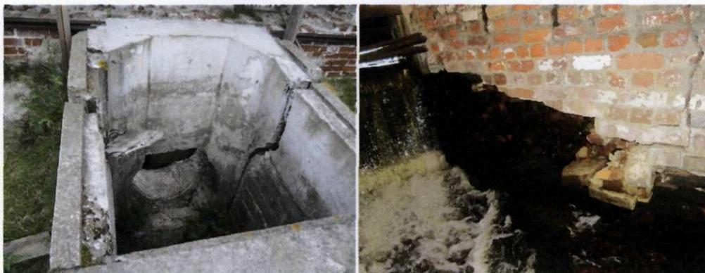
Рис. 21. Аварийное состояние каналов на Соловецком архипелаге (2 фрагмента)
