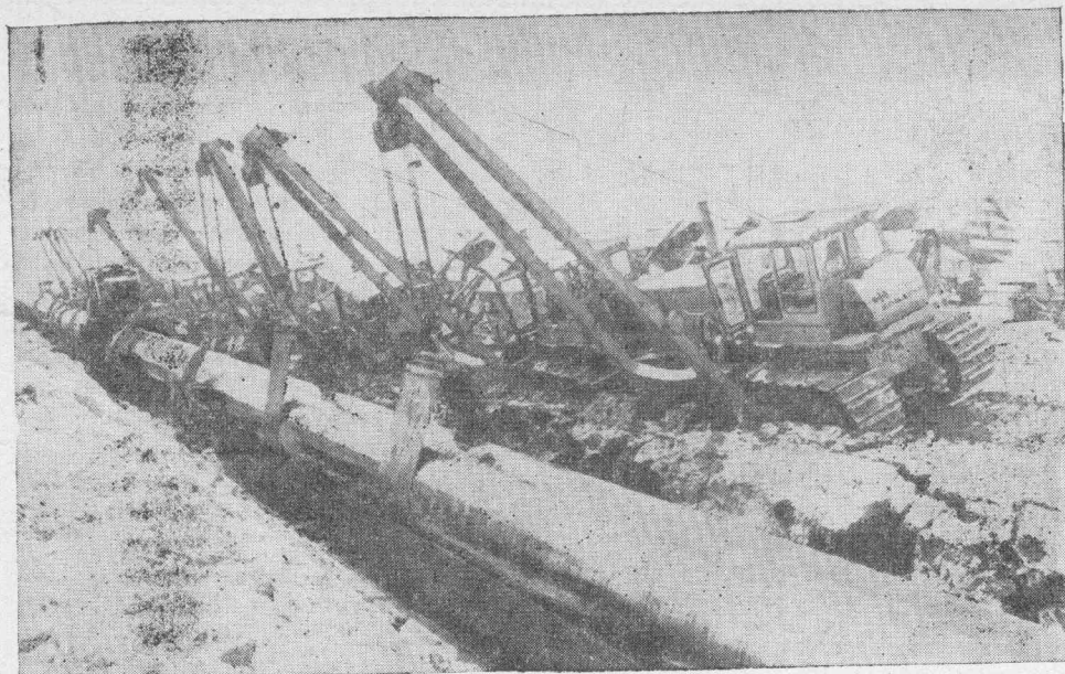
Фото 2. Стройка дружбы газопровод «Союз» (Оренбург — Западная граница СССР)
