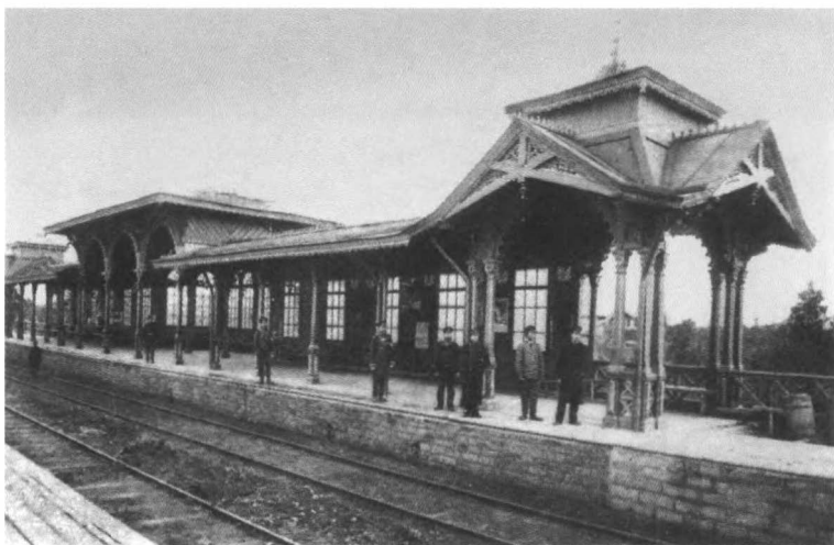
Станция Лигово Балтийской железной дороги. Фотография 1899 г.
