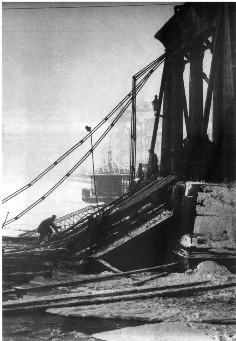
Разборка рухнувшего Египетского моста. Фотография 20 января 1905 г.
