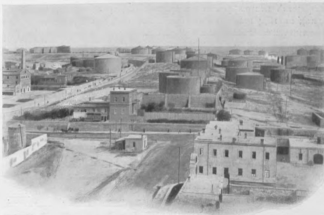
Керосиновые резервуары на заводѣ Т-ва въ Баку.
