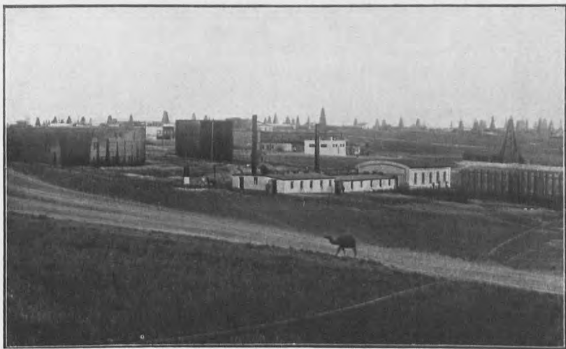
Резервуары и перекачечная станція Товарищества въ Балаханахъ въ 1885 г.
