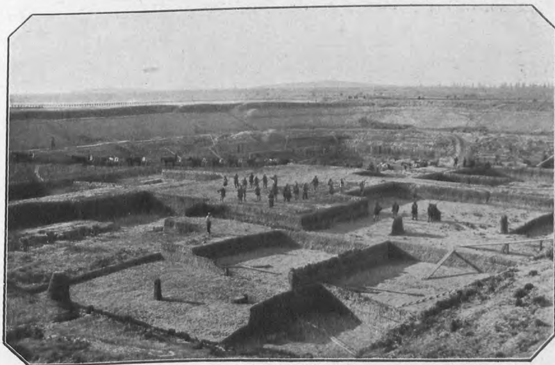
Сооруженіе земляного амбара для нефти.
