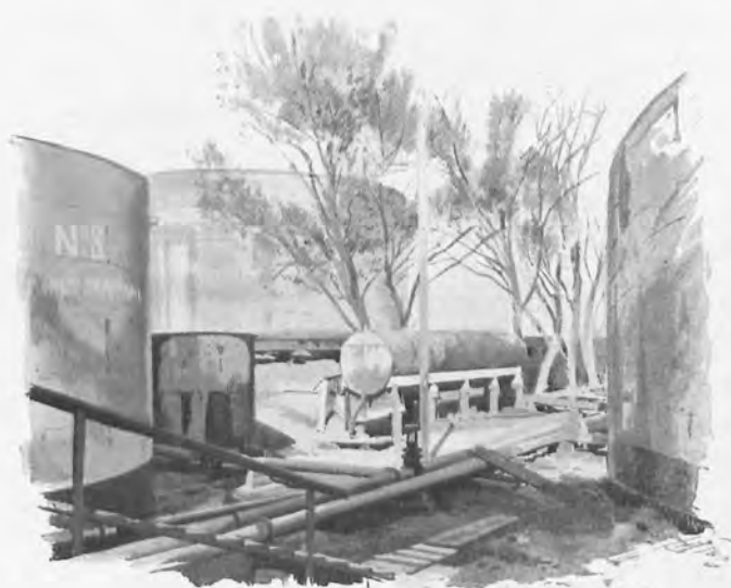
Часть Астраханскаго склада Товарищества (видны трубы большого діаметра).
