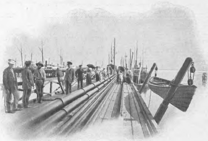
Трубопроводы на наливной пристани Товарищества.
