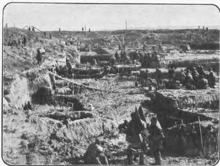
Сооруженіе земляного амбара для нефти. Начало земляныхъ работъ.
