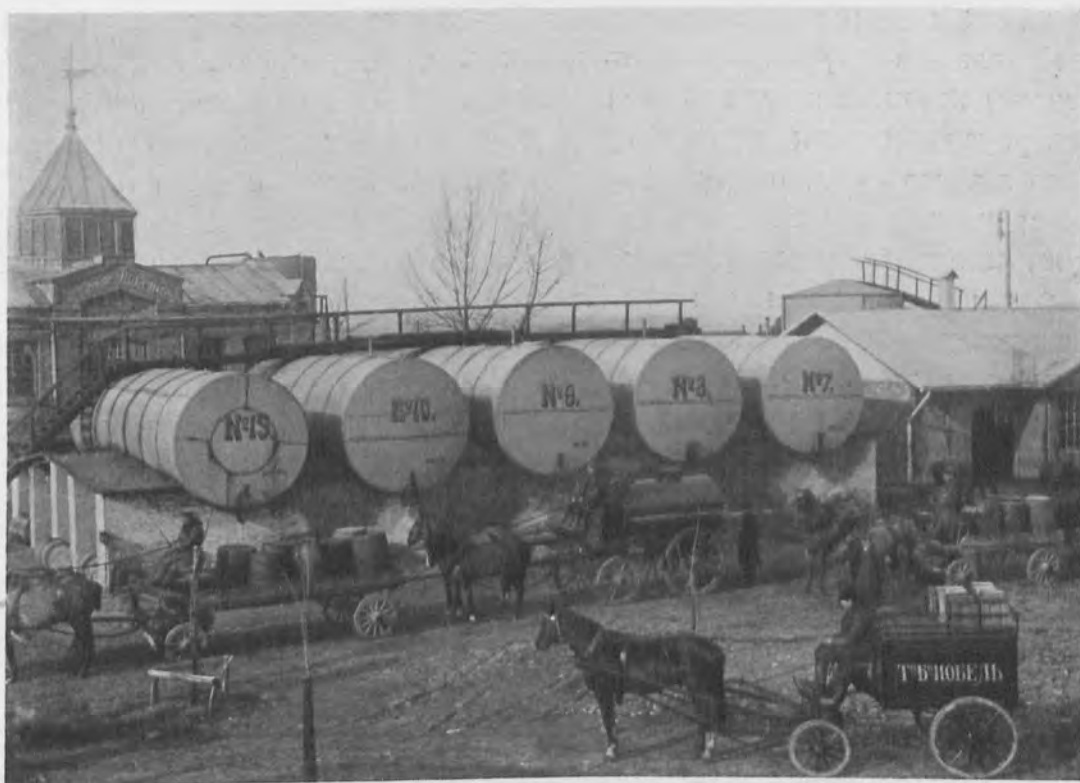
Лежачіе резервуары на складѣ Товарищества въ Варшавѣ.
