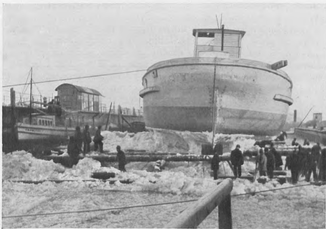
Постройка большой желѣзной баржи въ Кулебакахъ.
