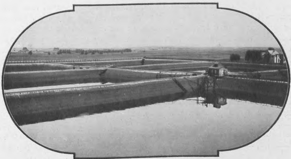
Мазутныя ямы на складѣ Товарищества въ Астрахани. Часть ихъ въ настоящее время засыпана и на ихъ мѣстѣ построены резервуары.
