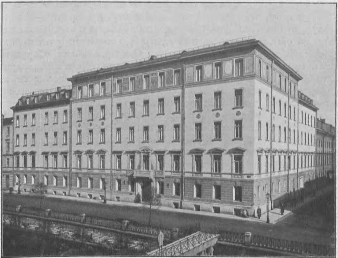
Домъ Товарищества Бр. Нобель на Екатерининскомъ каналѣ, гдѣ помѣщается съ 1910 г. Правленіе.
