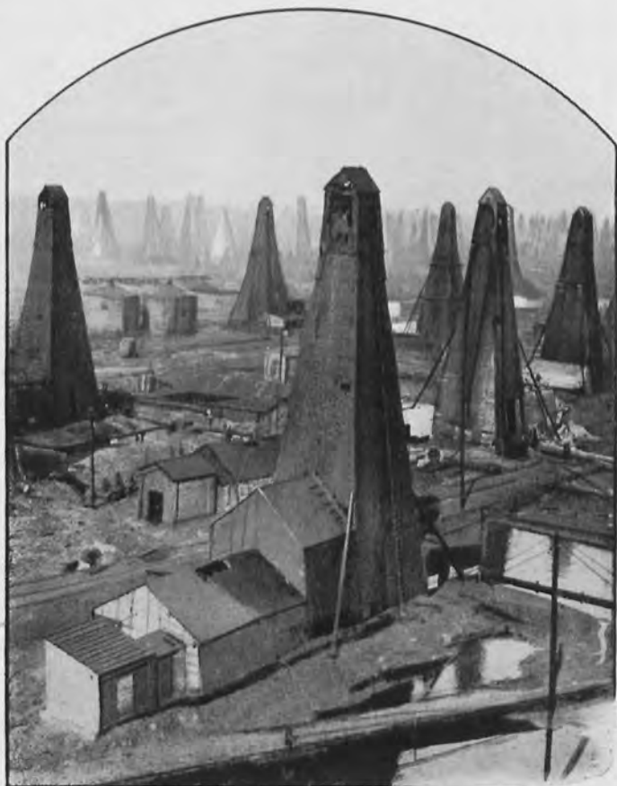
Вышки, обшитыя огнеупорнымъ матеріаломъ.
