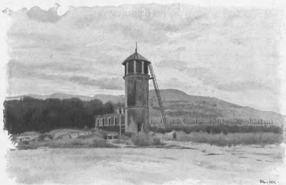
Водопроводъ при складѣ Товарищества въ Увекѣ.
