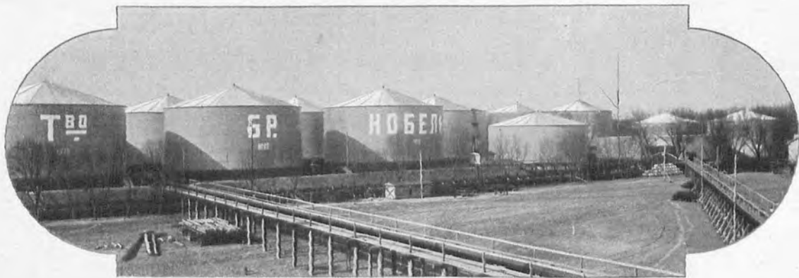
Резервуары и трубопроводы къ нимъ.
