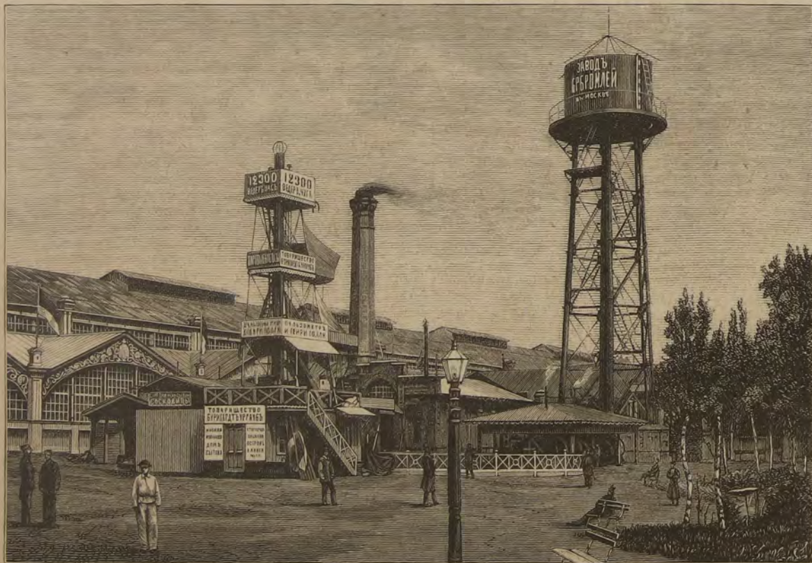
Пульзометръ Буркгардта и Урлауба и напорная башня завода братьевъ Бромлей.
