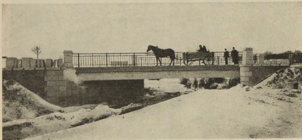
Рис. 12. Желѣзо-бетонный мостъ около Троппау, прол. 14 метровъ (сист. Геннебика). Ширина моста 7 метровъ.
