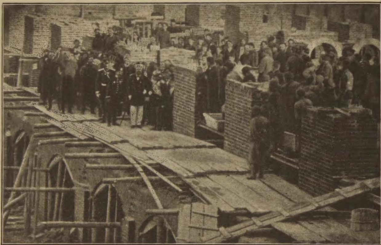
Осмотръ Почетнымъ Предсѣдателемъ строительныхъ работъ.
