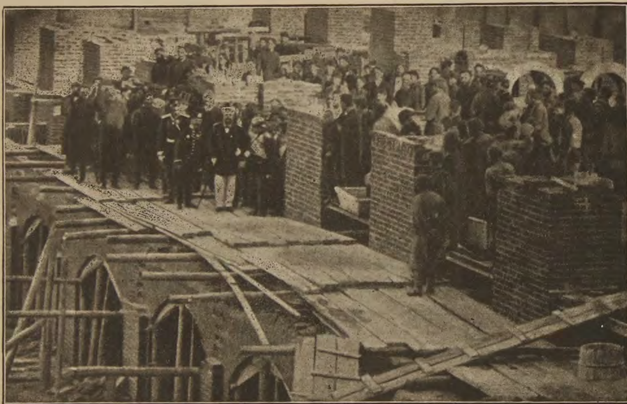
Осмотръ Почетнымъ Предсѣдателемъ строительныхъ работъ.
