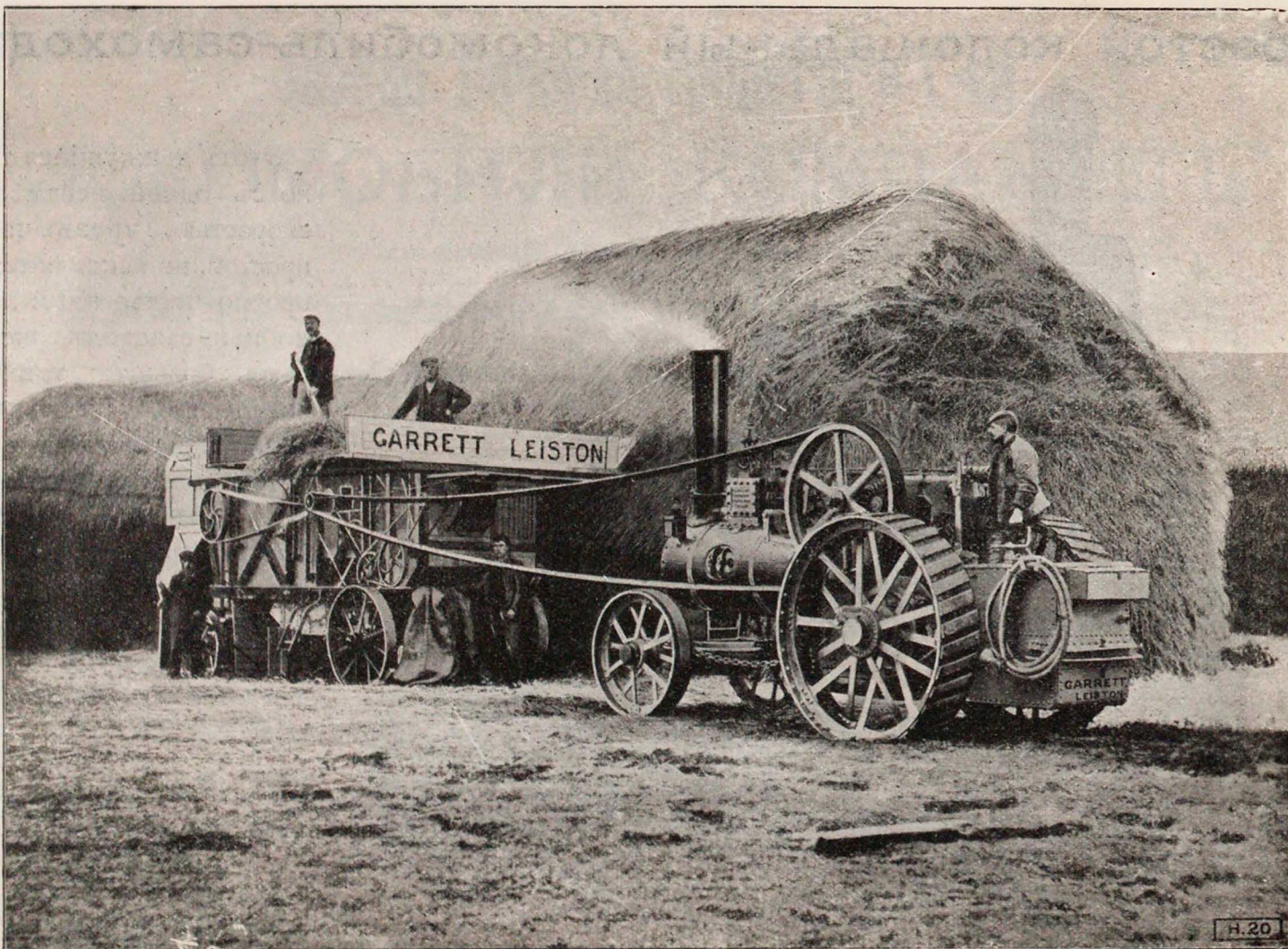
Локомобиль-самоходъ, приводящій въ дѣйствіе паровую молотилку.
