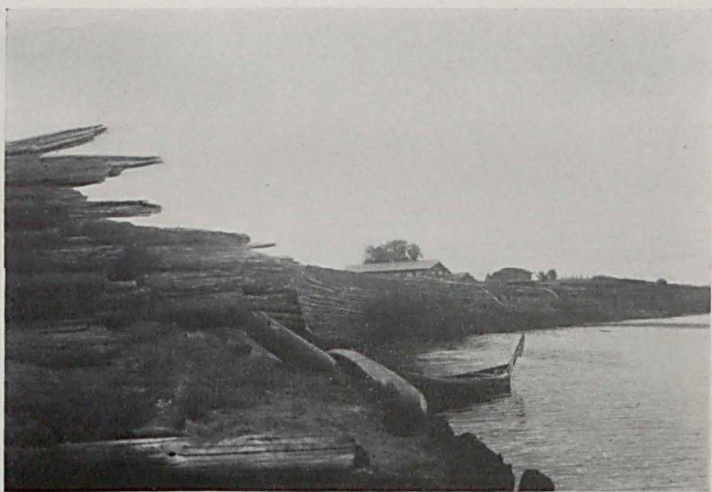
Правый берегъ, вер. 27. Разрушенная ряжевая набережная у города Сольвычегодска.
