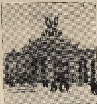
Надземный вестибюль станции «Арбатская площадь»
