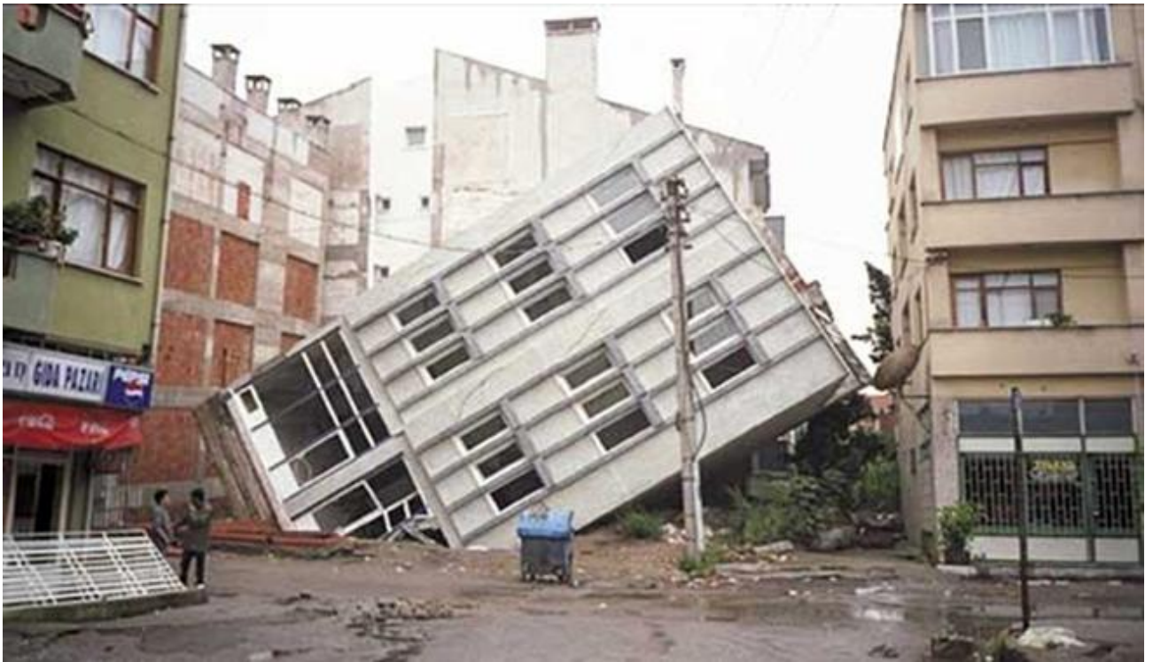
Рис. 1.7. Разжижение грунта или ликвифекшн.
