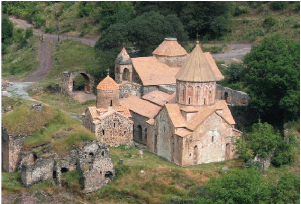
Դադիվանքի յուշարձանախումբը: Տեսքը հարավ-արեւելքից (լուս.՝ Ս. Այվազեանի) The Dadivank monument complex. View from the south-east (photo by S. Ayvazyan)
