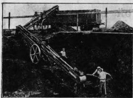
Подача из строительной котловины Передвижной ковшевой элеватор в работе
