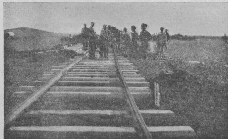
Рис. 11. Укладка пути на 13 км южного участка.
