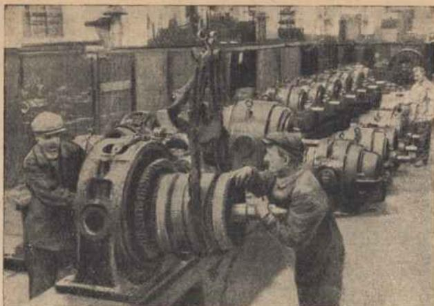
Сборка электромоторов для шахт Донбасса.
