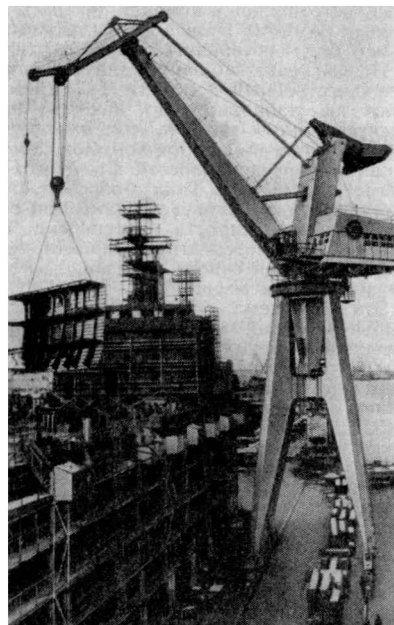
80-тонный порталный кран на стапеле судостроительного завода.
