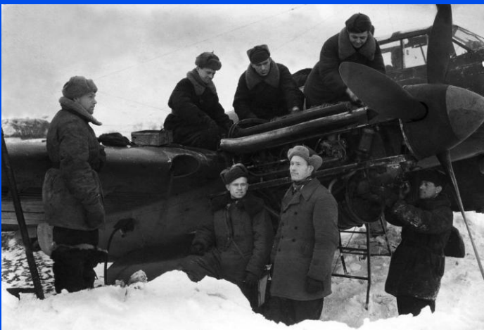
Замена двигателя у самолета П. А. Плотникова (стоит у самолета второй слева).
