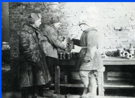
В арматурном цехе Барнаульского котельного завода.
