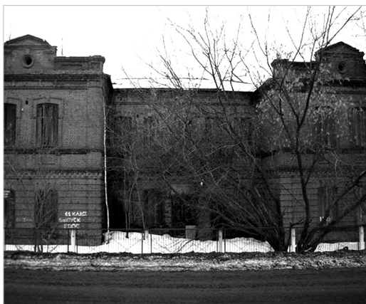
Здание Вожгальского училища. с. Вожгалы. [2000-е гг.]
