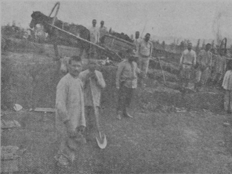
Заглядывающій работѣми Леоновичъ на мѣстѣ работъ.
