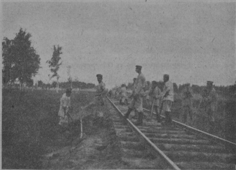
Арестанты работаютъ по укладкѣ пути на времянкѣ.
