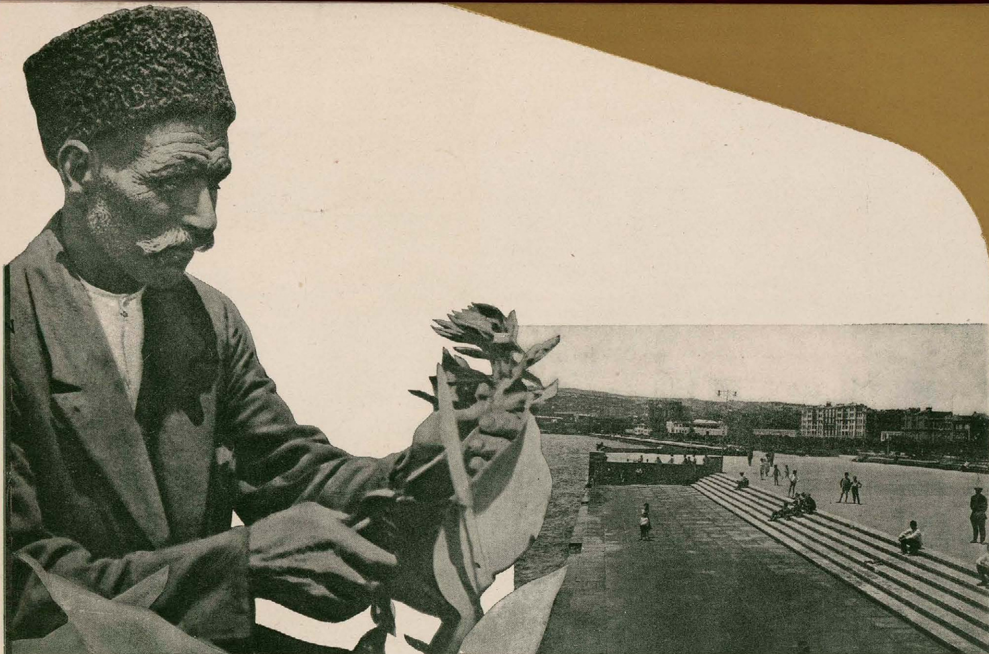
Новый приморский бульвар в Баку
