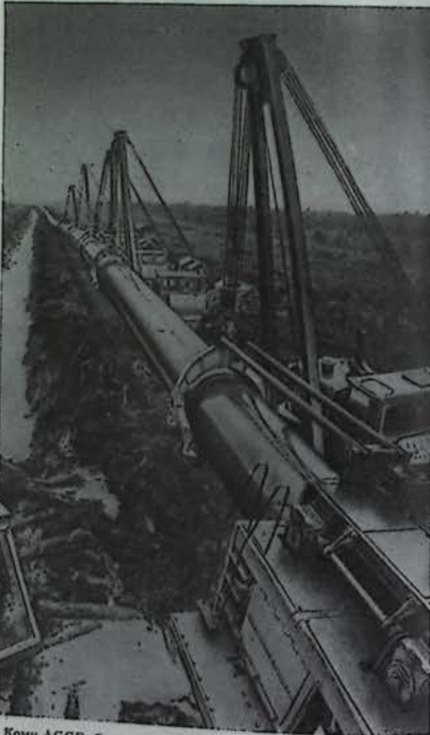
Коми АССР. Строится новый газопровод Пунга — Вуктыл — Грязовец.
